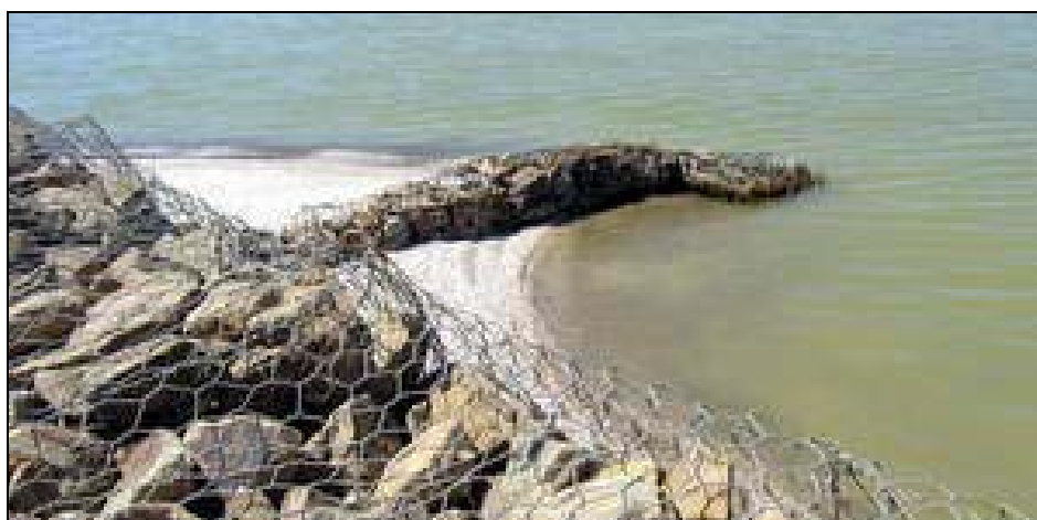
Рисунок 7.25 – Деформированная бунa на берегу Чумбурской косы (Фото Крыленко М.В)
