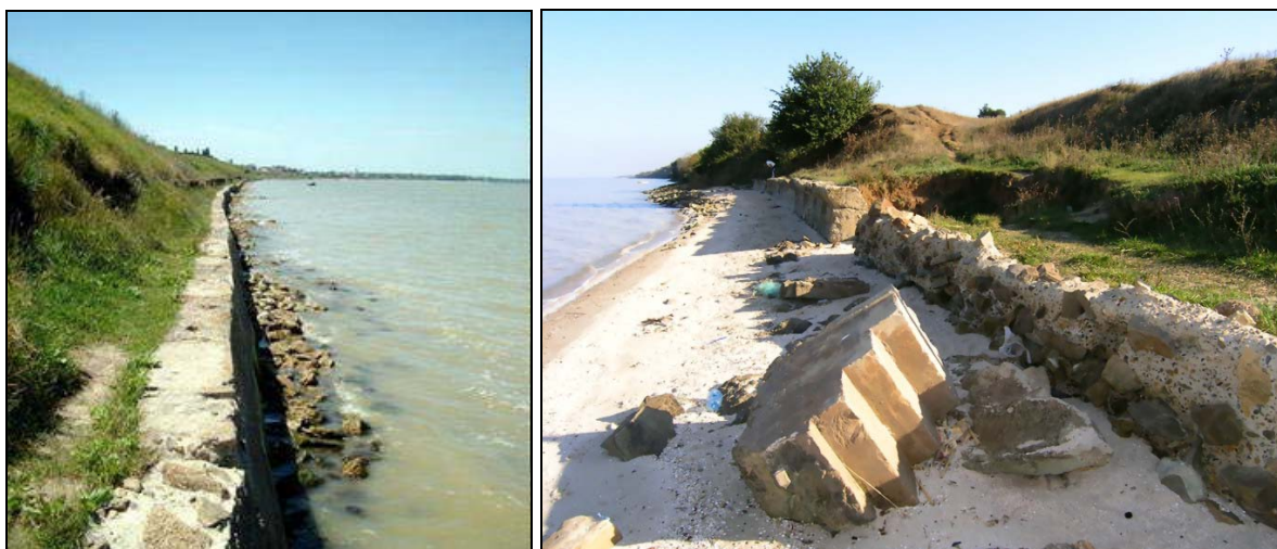
Рисунок 7.23 – Волноотбойная стенка и каменная наброска, сделанные для защиты железнодорожного полотна в пос. Широчанка (Фото Крыленко М.В)
