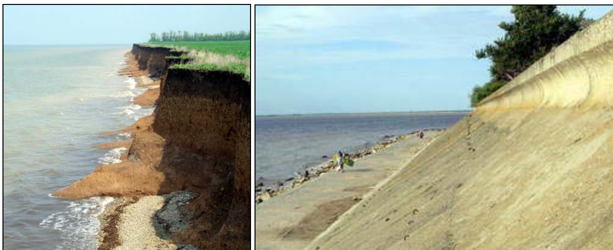
Рисунок 7.19 – Абразионный клиф и берегоукрепление у х. Морозовский (Фото Пешкова В.М., Крыленко М.В)
