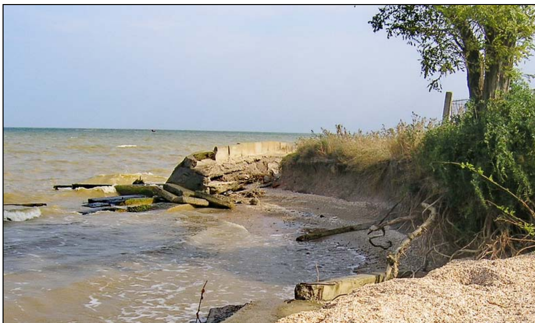
Рисунок 7.22 – Остатки волноотбойной стенки (Фото Крыленко В.В.)
