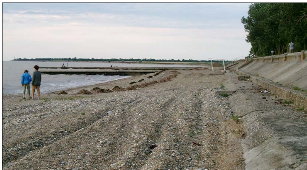
Рисунок 7.18 – Волноотбойная стенка и искусственный галечный пляж турбазы “Лотос” (Фото Крыленко М.В)
