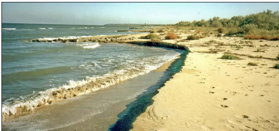
Рисунок 7.14 – Гребенка бун пока удерживает от размыва пляж на косе Чушка (фото с сервиса panoramio.com)
