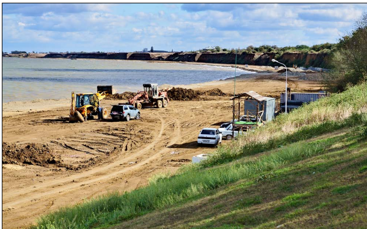
Рисунок 7.42 – Защита прибрежной застройки г. Тамань от разрушения. Комплекс защитных мер предусматривает укрепление абразионного клифа, отсыпку защитной бермы, создание рекреационного пляжа и набережной (Фото Пешкова В.М.)
