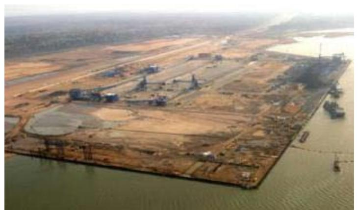
Рисунок 3.54 - Образование намывной территории Беломорского глубоководного порта и строительство причальных сооружений
