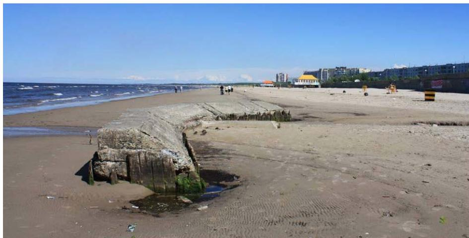
Рисунок 3.43 - Защитное сооружение над сливной трубой и волноотбойная стенка в тыловой части пляжа (Фото Д.В.Рябчук)
