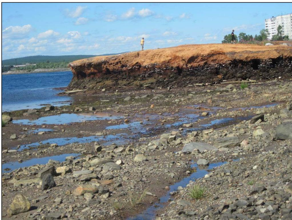
Рисунок 3.50 - Размыв техногенного (насыпного) берега. Район застройки городской застройки в южной части города. (Фото Рыбалко А.Е.)
