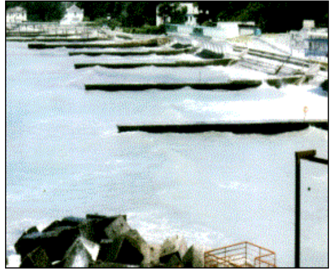
Рисунок 8.29 - Пустые межбунные отсеки берегозащитных сооружений. На левом снимке – участок Туапсинской железной дороги, на правом – район Большого Сочи
