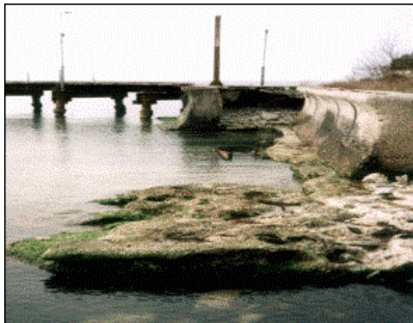
Рисунок 8.27 - Разрушенная волноотбойная стенка в СЗ части Голубой бухты
