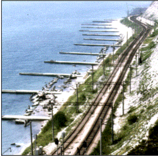
Рисунок 8.29 - Пустые межбунные отсеки берегозащитных сооружений. На левом снимке – участок Туапсинской железной дороги, на правом – район Большого Сочи
