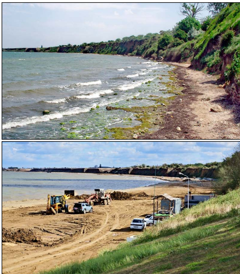
Рисунок 10.76 – Берегоукрепление участка берега Таманского залива у ст. Тамань, сверху – до начала работ; внизу – в процессе работ (Фото Пешкова В.М.)
