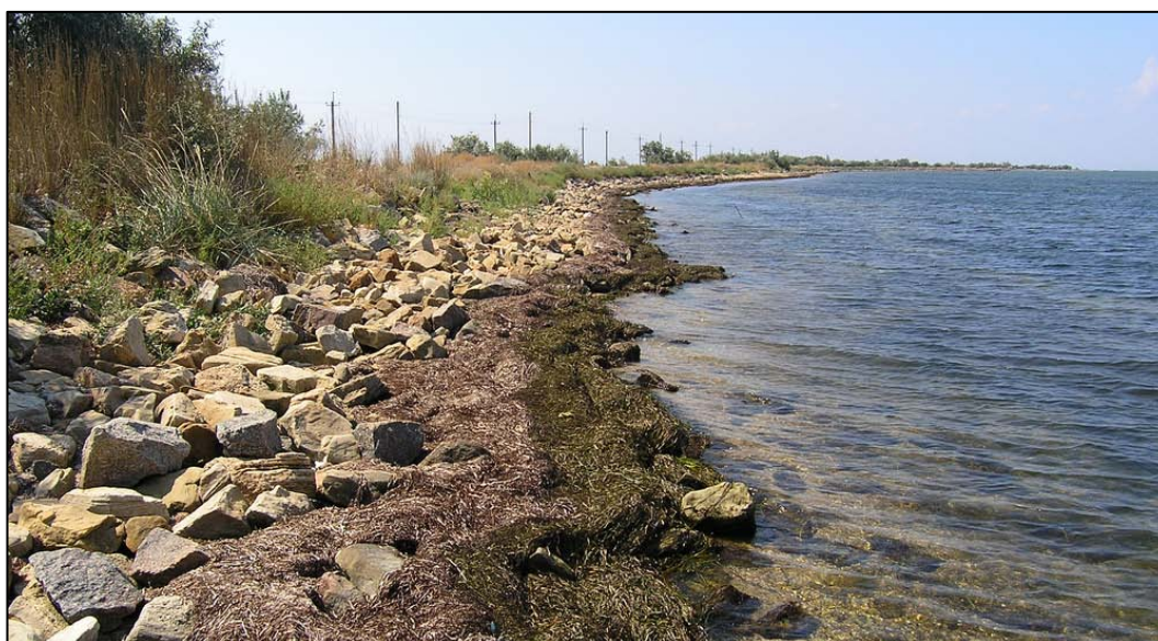
Рисунок 10.89 – Южнее порта Кавказ западный берег косы Чушка укреплен отсыпкой каменного материала (фото Крыленко В.В.)
