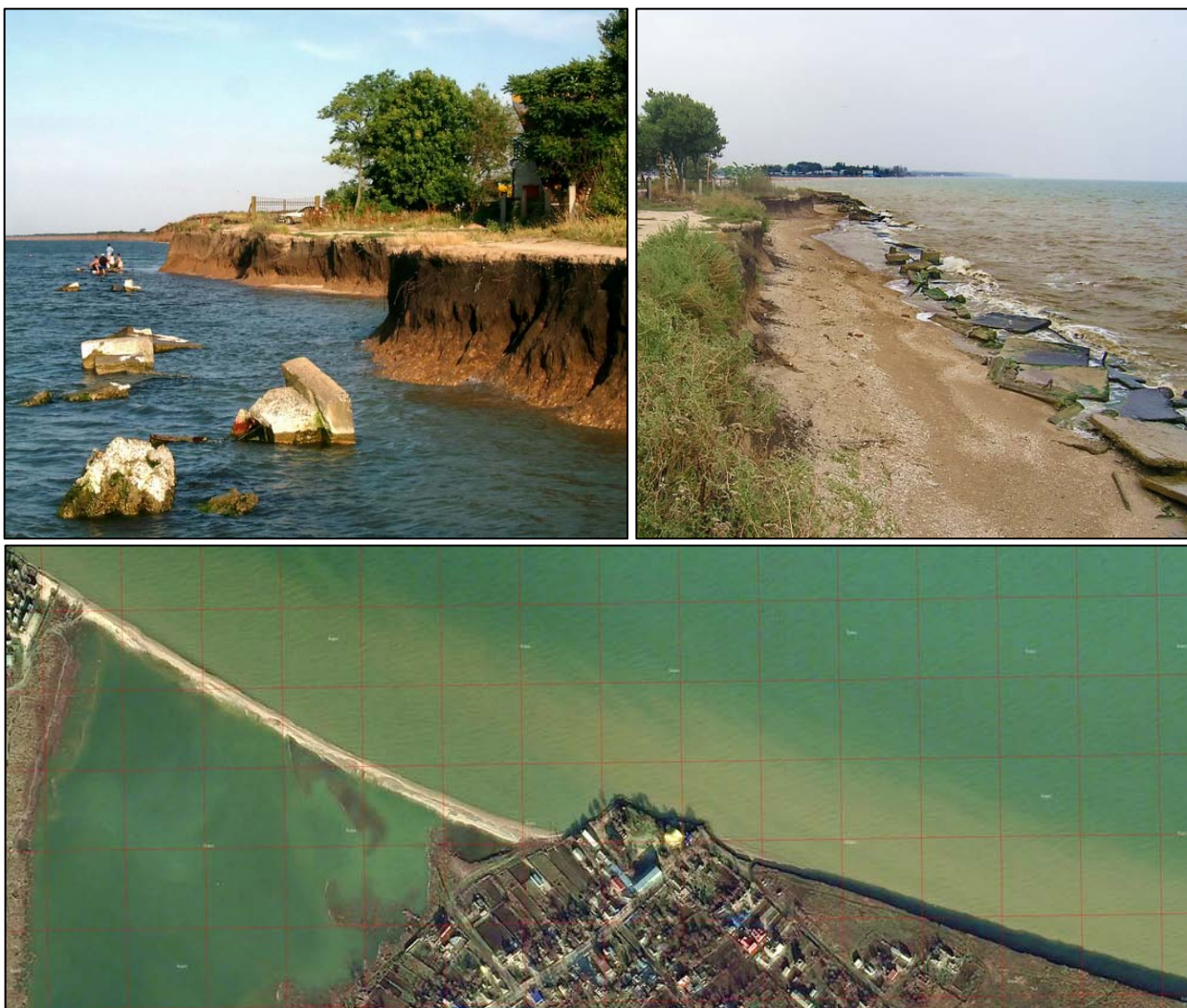
Рисунок 10.133 – Берегоукрепление на участке д/о «Азов» в ст. Должанской (Таганрогский залив) практически полностью разрушено, но под его прикрытием образовался искусственный абразионный мыс
