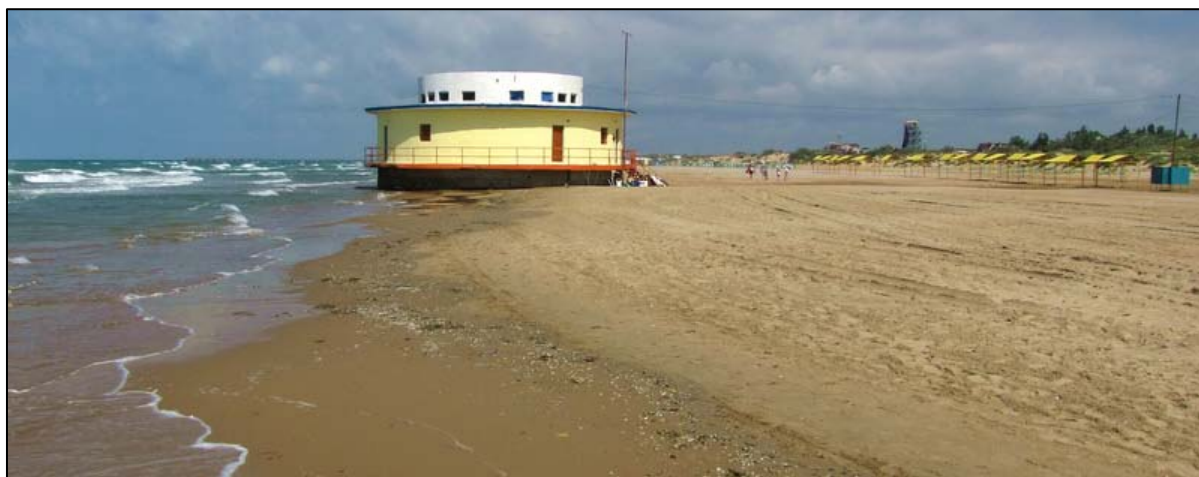
Рисунок 10.54 – Капитальные сооружения в районе профиля 9 (2012 г.)
