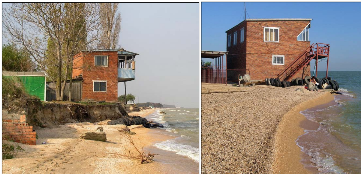
Рисунок 10.124 – Попытки локальной защиты берега косы Долгой кустарными способами
