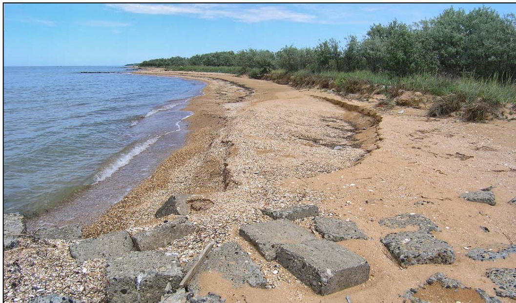
Рисунок 10.88 – Гребенка бун пока удерживает от размыва пляж на западном берегу косы Чушка (фото Крыленко В.В.)
